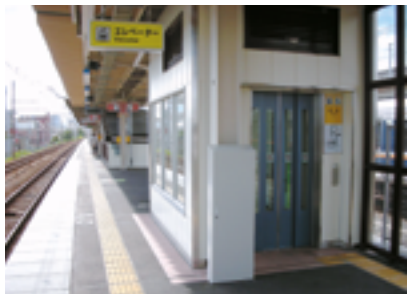
▼甲子園駅エレベーター設置
