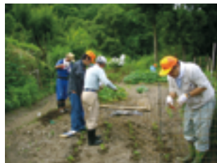
▲防護柵の設置
