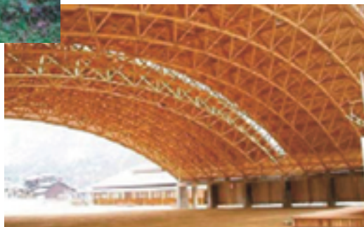
▲県産木材を使用したアイビードーム
